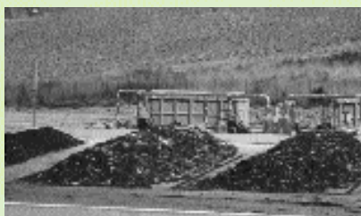
Vista del piazzale di bioossidazione accelerata, dell'impianto di insufflazione-aspirazione e dei biofiltri.
