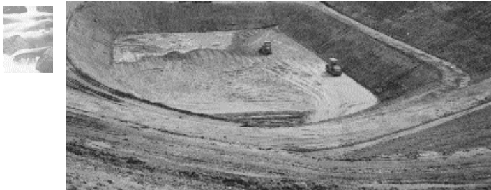
Vista della discarica di Le Macchiaie durante i lavori di realizzazione dell'invaso.
