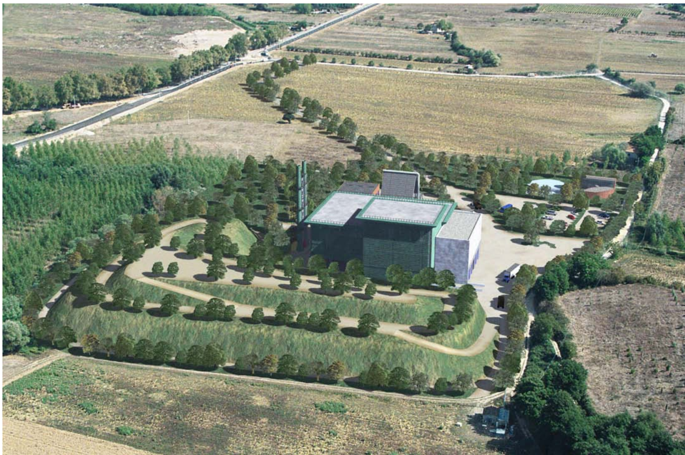
Rappresentazione fotorealistica dell'impianto di termoutilizzazione di Pian dei Foci
