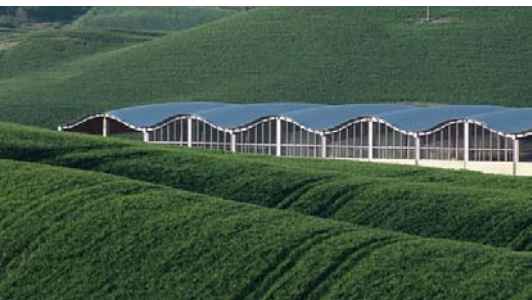
Particolare dell'impianto di selezione, compostaggio e valorizzazione a Pian delle Cortine
